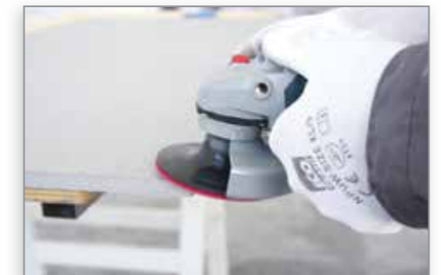
CIĘCIE PŁYTEK COKOŁOWYCH POD KĄTEM
